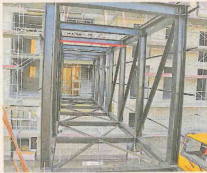
Die Stahlkonstruktion verbindet bereits das Hotel und das Schwimmbad. Fehlen noch Verkleidung und Türen. Foto: Engels
