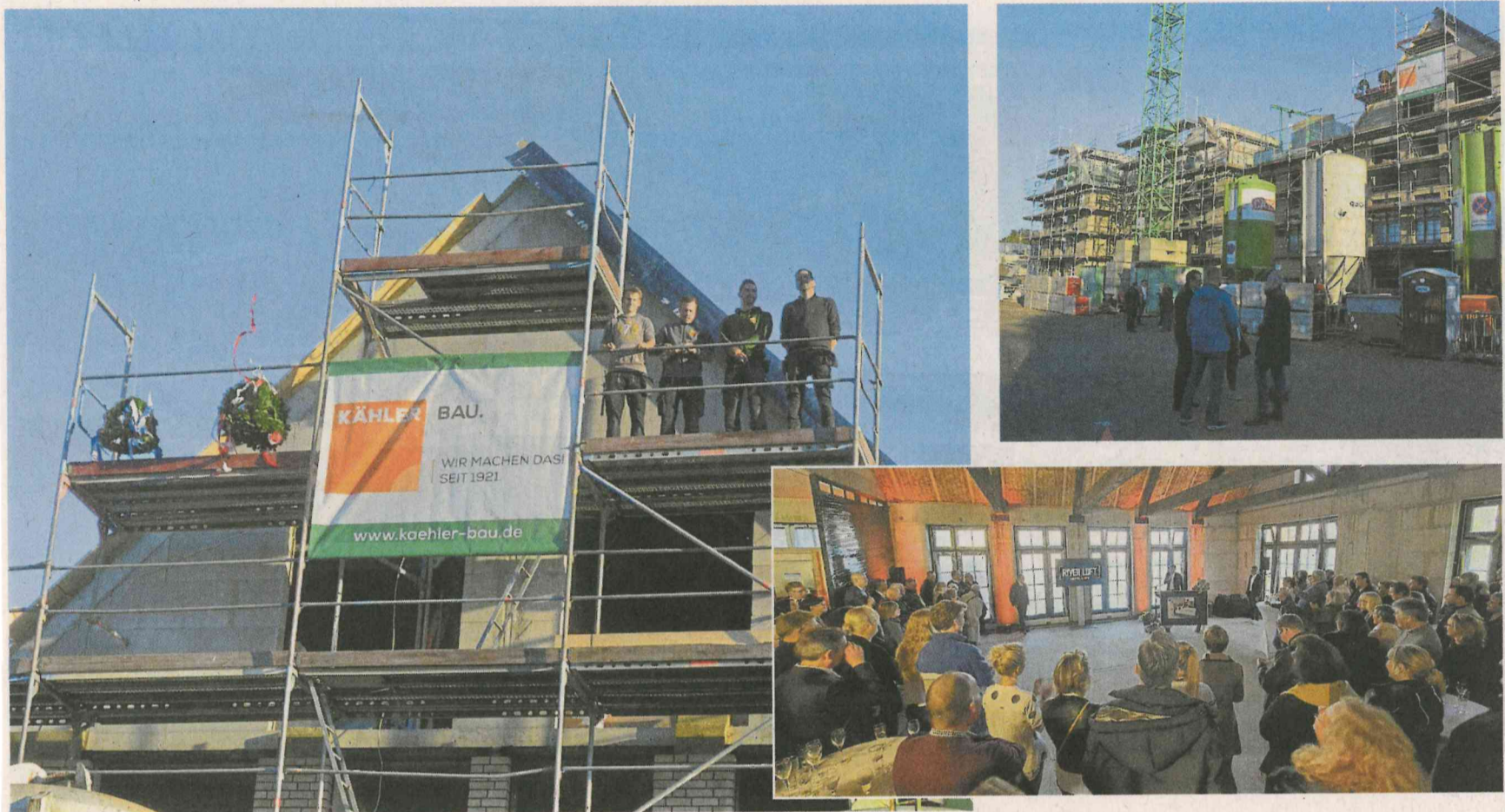
Links und oben rechts: Das Dach des River Loft Hotels ist fertig, nun wurde Richtfest gefeiert. Unten rechts: Im zukünftigen Restaurant „Outer Roads“ wurde gefeiert. Foto: Thode (2)/ Westküsten-News
